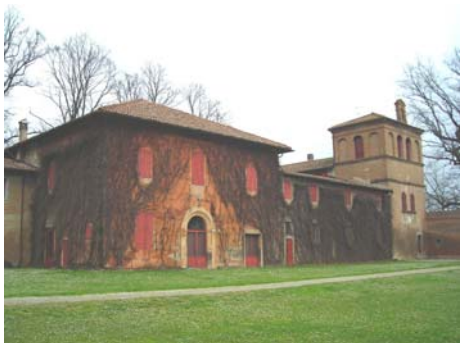
Palazzo Minelli, Sala Bolognese, via Reatti
