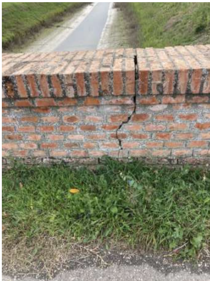
Figura 7-6 Lesioni del parapetto
