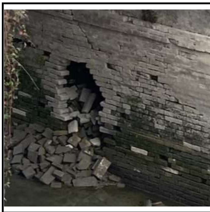
Figura 7-1 Foro muratura spalla nord
