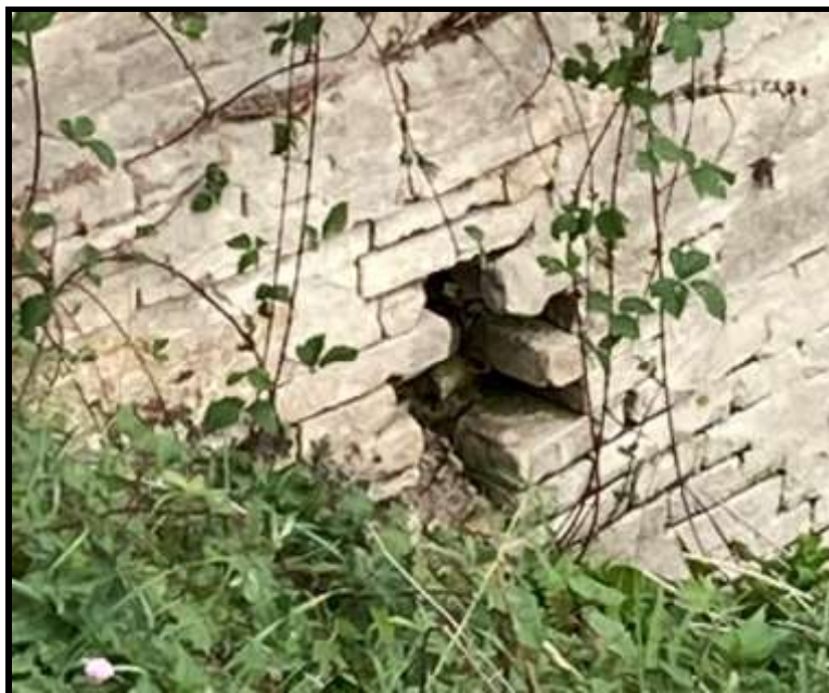
Figura 7-2 Foro presente sul muro d'ala
