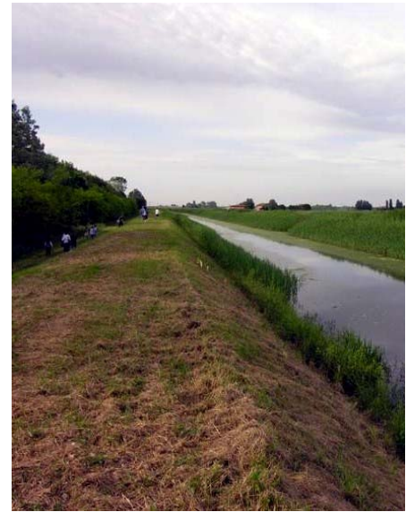
Es. Canale Acque Alte Il canale scorre sopra il piano culturale
